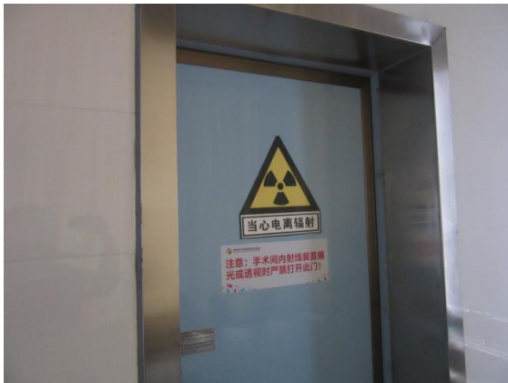
图 3-21 控制室出入机房防护门（介入 2 室）
