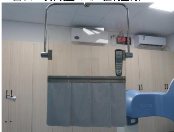
图 3-11 悬吊铅屏风（介入 1 室）
