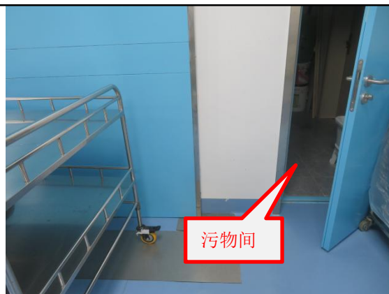
图 3-8 污物间出入机房防护门（介入 1 室）
